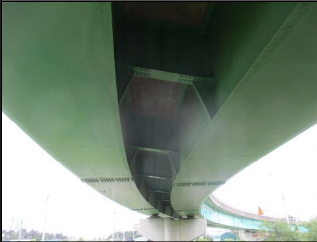
거더, 가로보 전경
