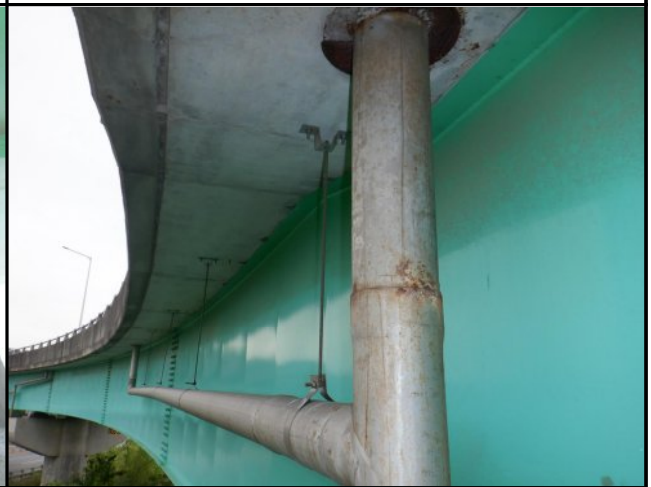
바닥판 캔틸레버, 배수관 전경
