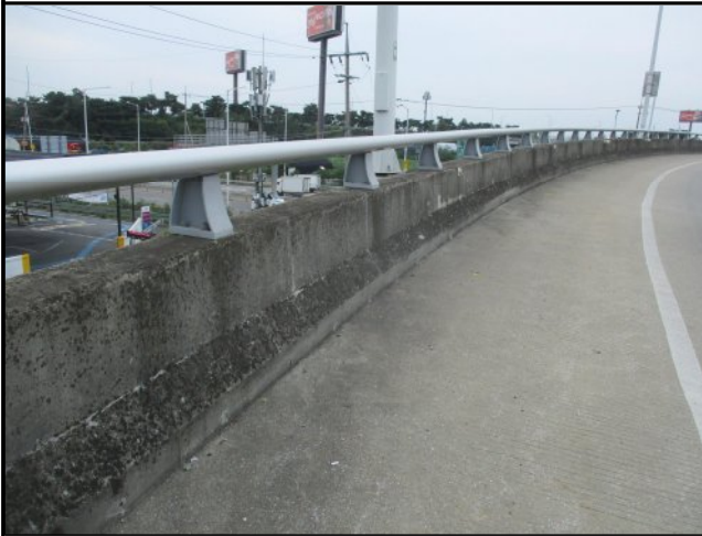
난간 및 연석 전경
