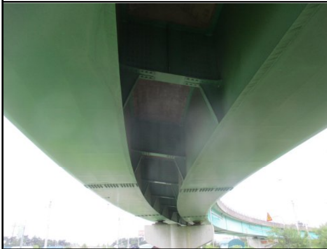
거더, 가로보 전경
